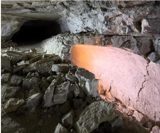
Gauche : Rampe de communication, la voûte déformée par la pression décrit maintenant un angle droit. Droite : Dans la même rampe, une niche permettant le croisement entre ouvriers et véhicules ferrés.
