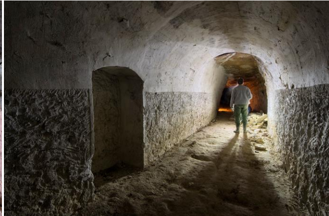
Gauche : Rampe de communication, la voûte déformée par la pression décrit maintenant un angle droit. Droite : Dans la même rampe, une niche permettant le croisement entre ouvriers et véhicules ferrés.
