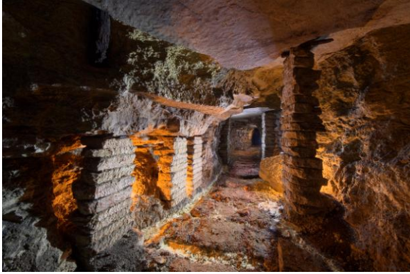
Gauche : Malgré son apparence saine, cet ancien roulage agrémenté de cales à bras est très dangereux d'accès. Droite : D'anciennes galeries de seconde masse soutiennent péniblement les lourds piliers de l'étage supérieur...
