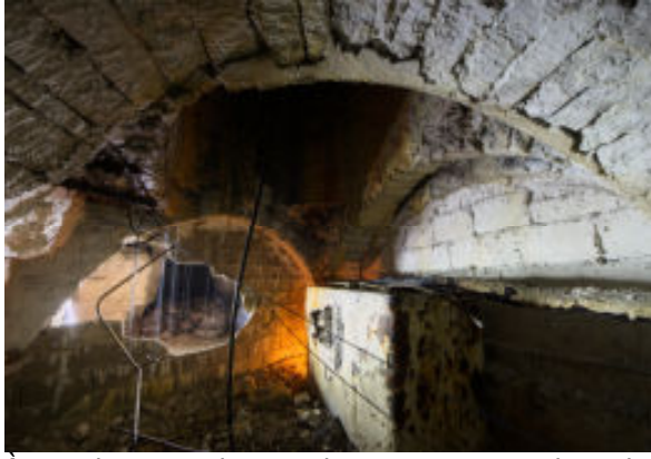
À gauche, un puits ovoïde soutenu par trois arches disposées en triangle, le bassin servait à récupérer l'eau alimentant le circuit d'arrosage; à droite c'est un pilier conique surmonté de poutres métalliques et d'anciens rails recyclés.
