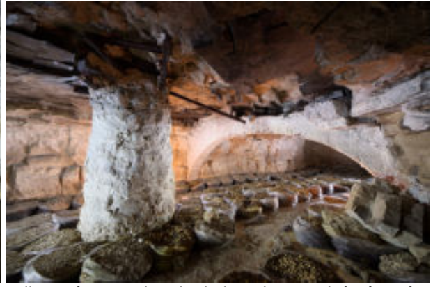
À gauche, un puits ovoïde soutenu par trois arches disposées en triangle, le bassin servait à récupérer l'eau alimentant le circuit d'arrosage; à droite c'est un pilier conique surmonté de poutres métalliques et d'anciens rails recyclés.
