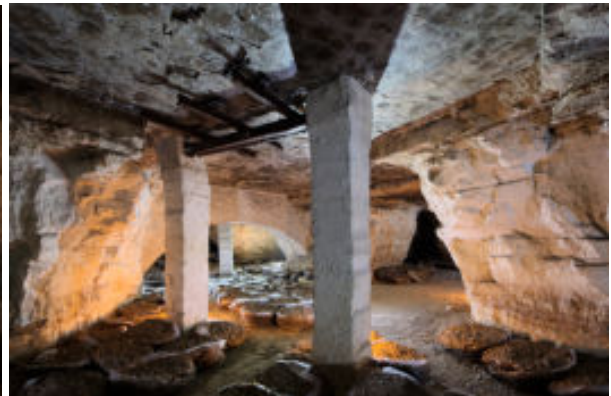
Divers piliers, on voit les blocs de marnes au ciel ayant tendance à se détacher. Les sacs plastiques contiennent le terreau à champignons et sont abandonnés là depuis des décennies...
