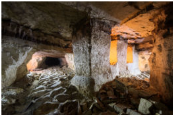
Divers piliers, on voit les blocs de marnes au ciel ayant tendance à se détacher. Les sacs plastiques contiennent le terreau à champignons et sont abandonnés là depuis des décennies...
