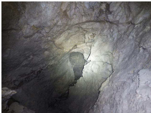
la galerie, vue vers l'aval.
