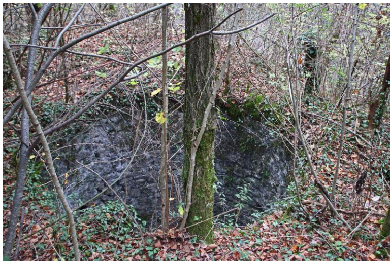
le sommet du puits.
