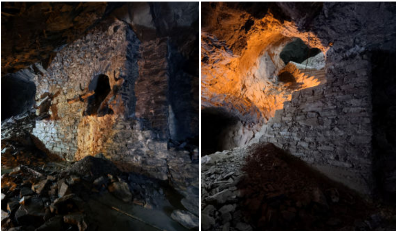
Escaliers et trémies jalonnent la galerie. Avec parfois de la voie !
