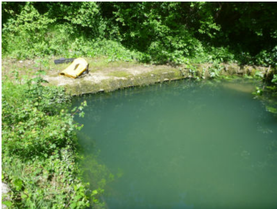
La sortie de l'eau à Bourne le 22 mai 2019 à 15 h 45 mn (la grille est à peine visible)
