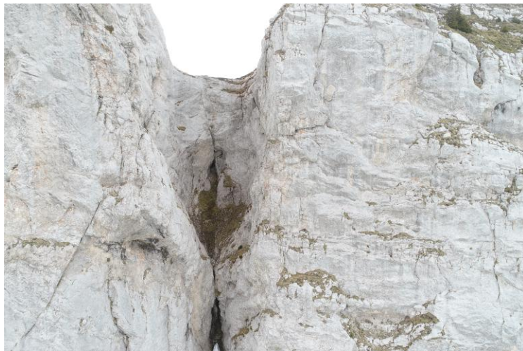
le haut de la brèche.
