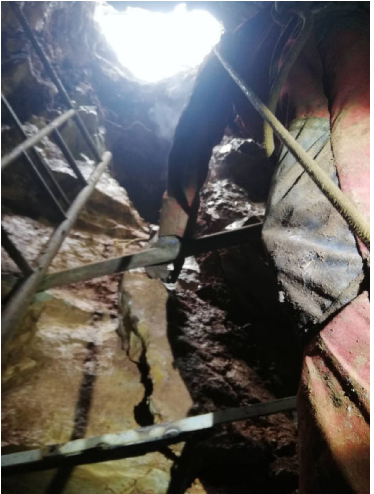
Vue vers le haut, avec les nouvelles structures en cours de pose.
