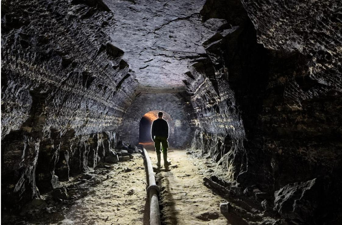
Les suies déposées par les engins mettent en évidence les différents bancs de gypse.
