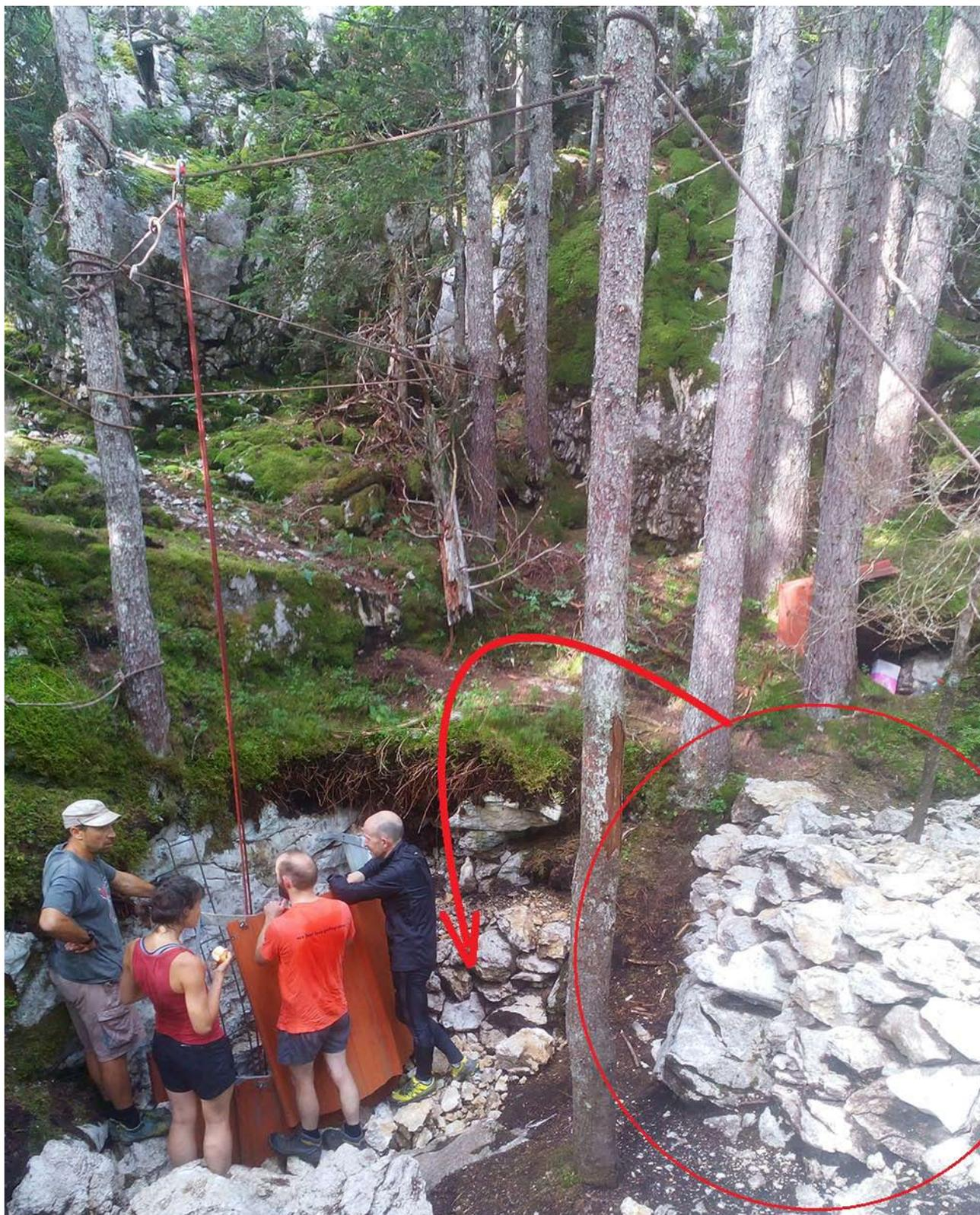
Pour la désobstruction, une poulie montée sur un câble tendu entre deux arbres nous a permis de remonter les blocs et de pouvoir les déplacer latéralement. A partir de la mi-août, quand la salle a été découverte et qu'on pouvait considérer la désobstruction de surface comme terminée, la murette ainsi construite a été re-manipulée par Barnabé et Raphaël, de manière à niveler le pourtour de la partie étayée, pour en masquer le bardage (ces travaux seront à achever en 2019).
