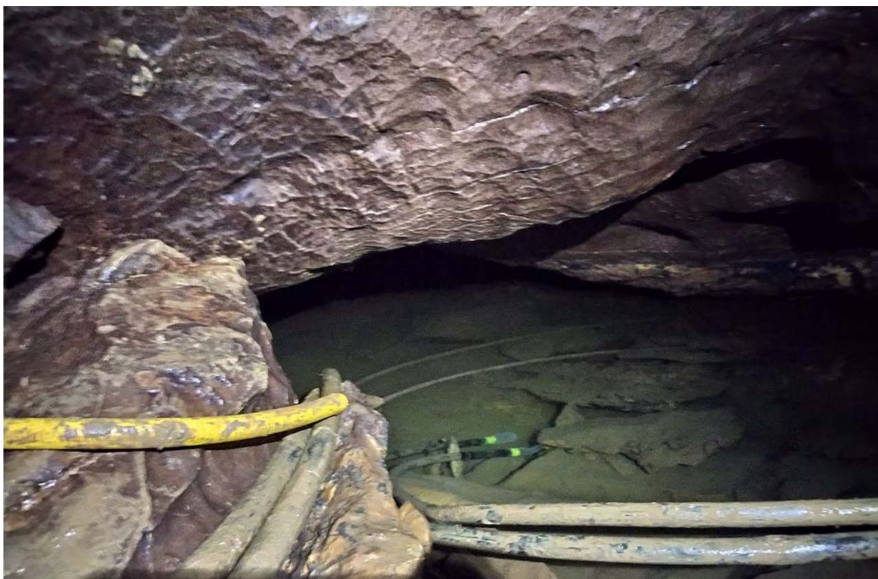
Double vidange en cours dans la seconde voûte mouillante
