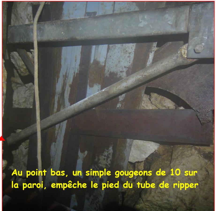
**Au point bas, un simple gougeons de 10 sur la paroi, empêche le pied du tube de ripper**
