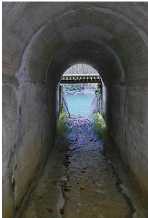
L'entrée vue de l'intérieur avec le Rhône au fond.
