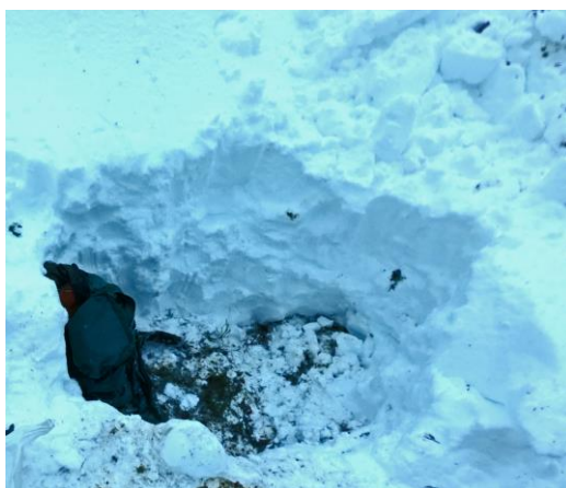
Le trou qui a permis de retrouver la ligne.
