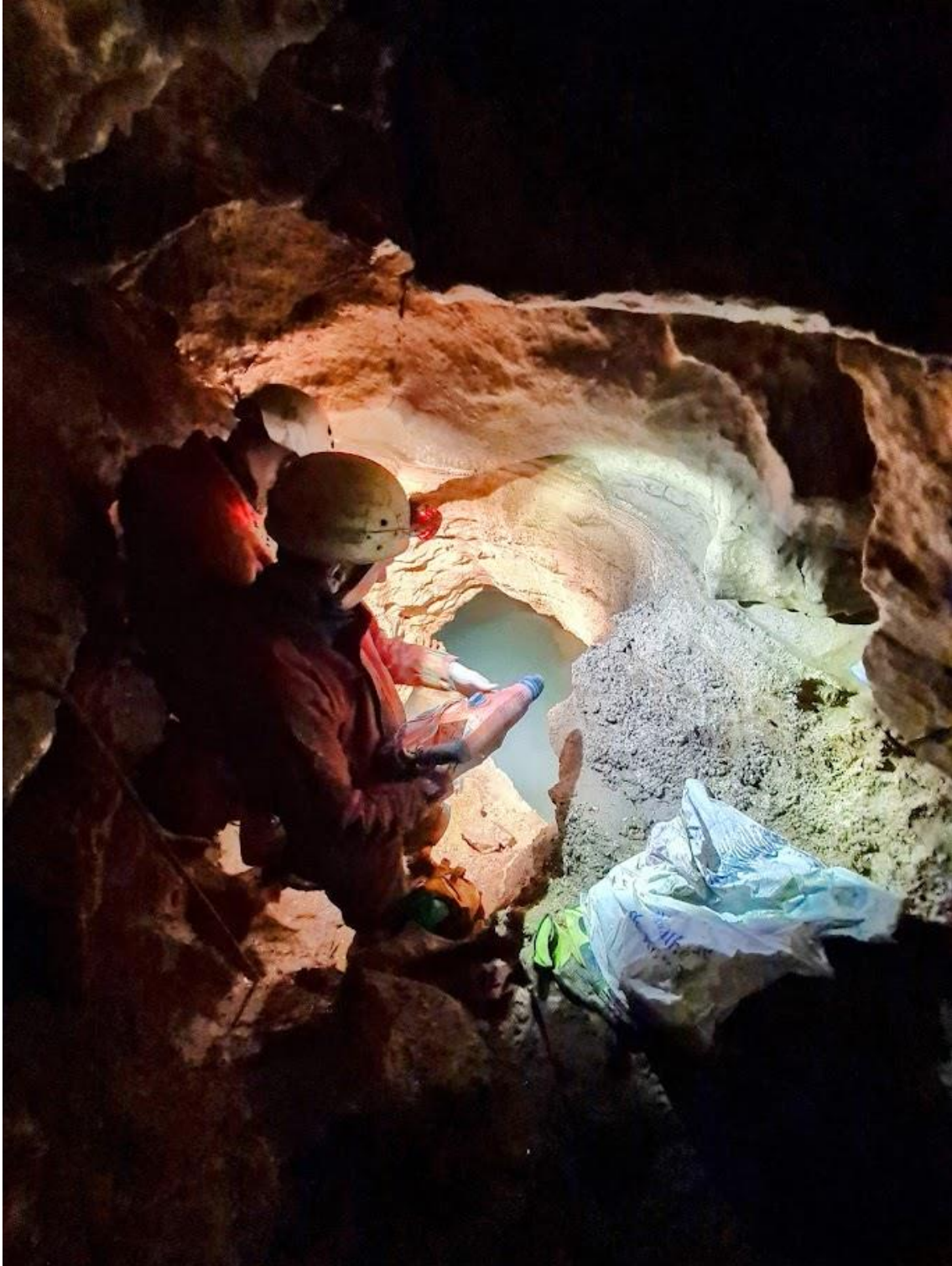
La zone de travail du jour. Quelques trous à percer.
