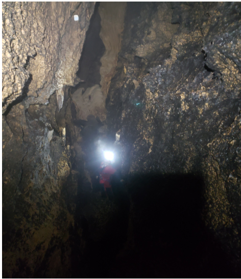
Illustration 4: Objet non-identifié encastré dans le plafond qui suppose beaucoup d'eau
