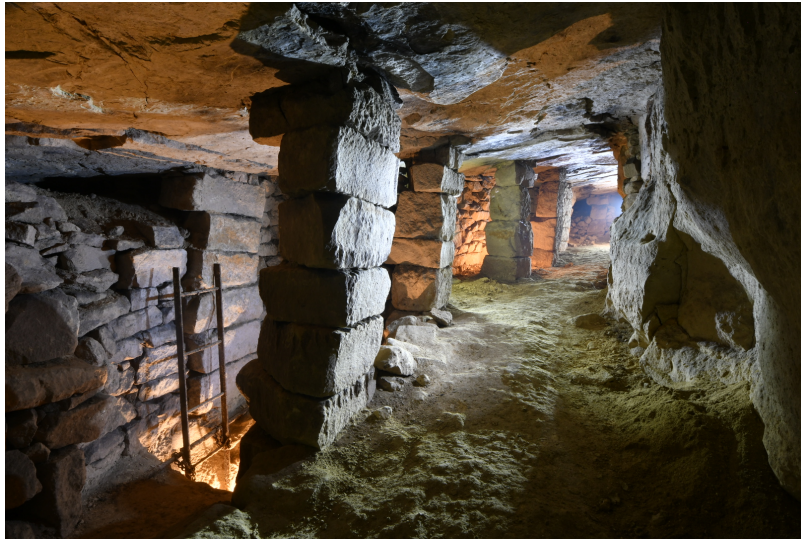
Galerie non-consolidée avec l'échelle du trou de communication.
