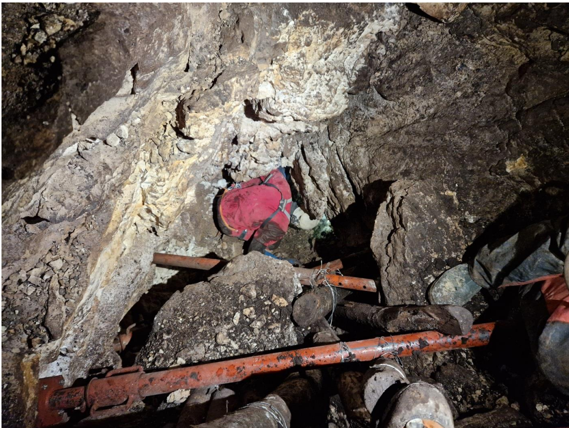
Figure 1 : Vue de la fin de la séance de désobstruction du jour au fond de la trémie soutenue (en date du 18/06/2023) par 4 étais et une dizaine de rondins.
