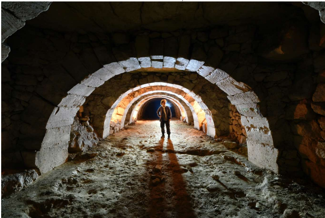
Passage obligé par cette remarquable consolidation... Une suite d'une vingtaine d'arches.
