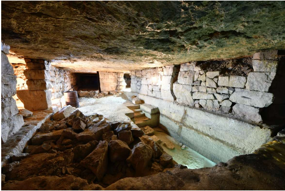
La carrière est jalonnée de bassins qui permettent de drainer l'eau. Certains, comme celui-ci, sont de taille remarquable. La carrière a été exploitée dès le XVII e siècle et la pierre a notamment été utilisée dans la construction de certaines parties du château de Versailles, avant de servir à l'époque haussmannienne.
