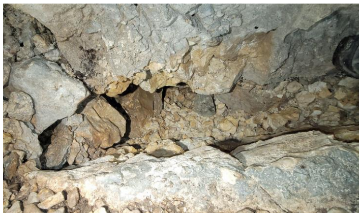
Le soupirail à creuser.
