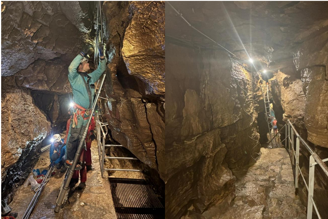
Mise en place des tubes inox dans les enfers
